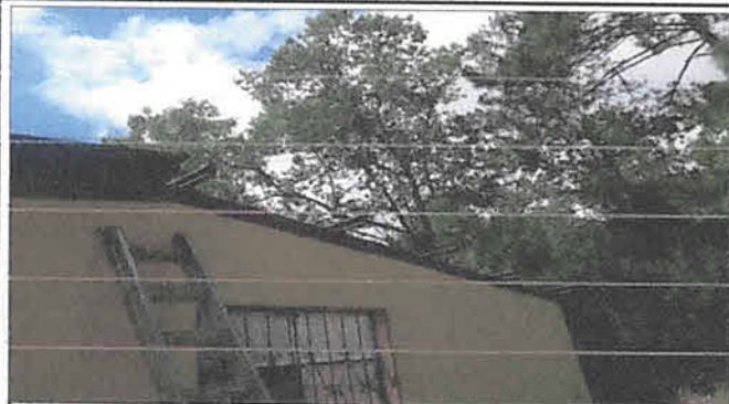
CAMBIO Y MANTENIMIENTO DEL TECHO E INFRAESTRUCTURA
