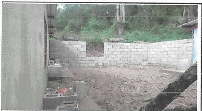
REMOZAMIENTO Y CAMBIO DE TECHO DE GALERA COMEDOR
